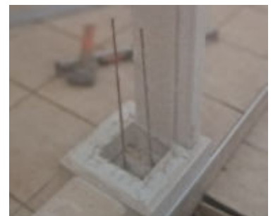
photo exemple ferrailage
