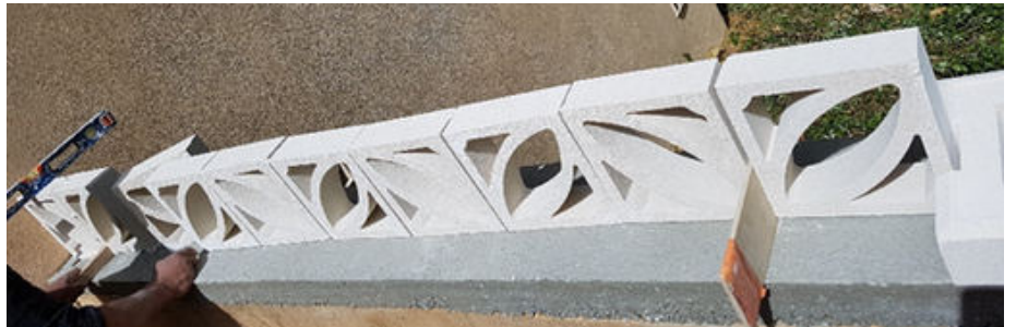
Photo montrant la base de pilier hauteur 115cm recoupée pour que la claustras soit positionnée contre le pilier
