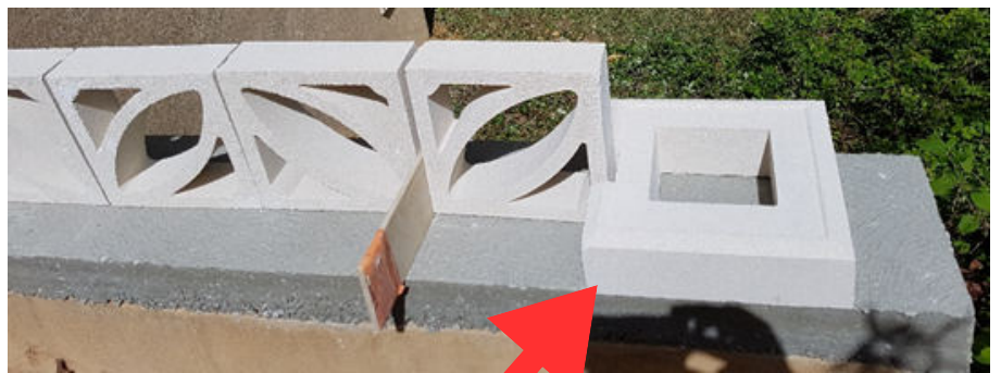
Photo montrant la base de pilier hauteur 115cm recoupée pour que la claustras soit positionnée contre le pilier
