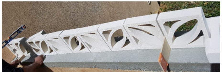
Photo montrant la base de pilier hauteur 115cm recoupée pour que la claustras soit positionnée contre le pilier
