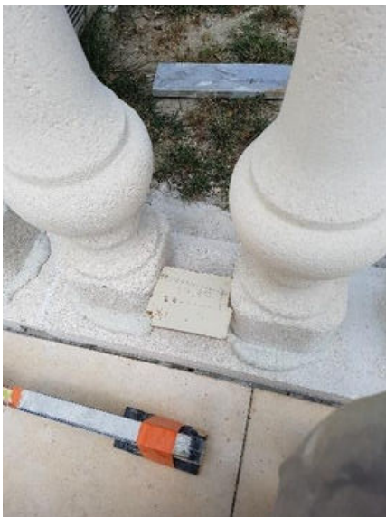
vérification avec gabarit
