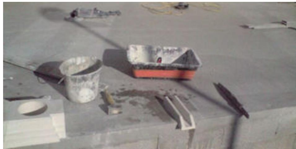
6. Placer les mains courantes et recouper la main courante avec l'aide d'une disqueuse afin que la gargouille rentre dedans.
