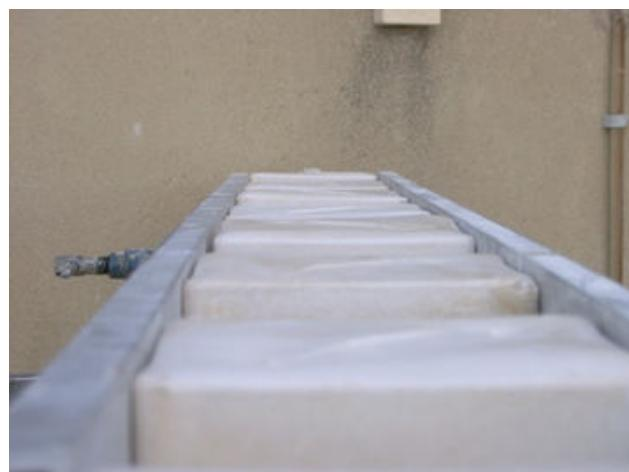
11. Ne pas oublier de vérifier les écartements des têtes de balustres, qui doivent être identiques au pied de la balustre.
