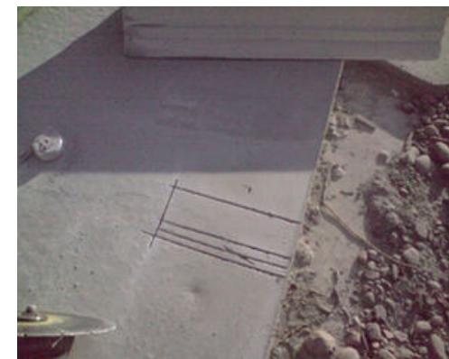
3. Avec l'aide d'un marteau (maillet) et d'un burin retirer des morceaux afin de pouvoir placer la gargouille.
