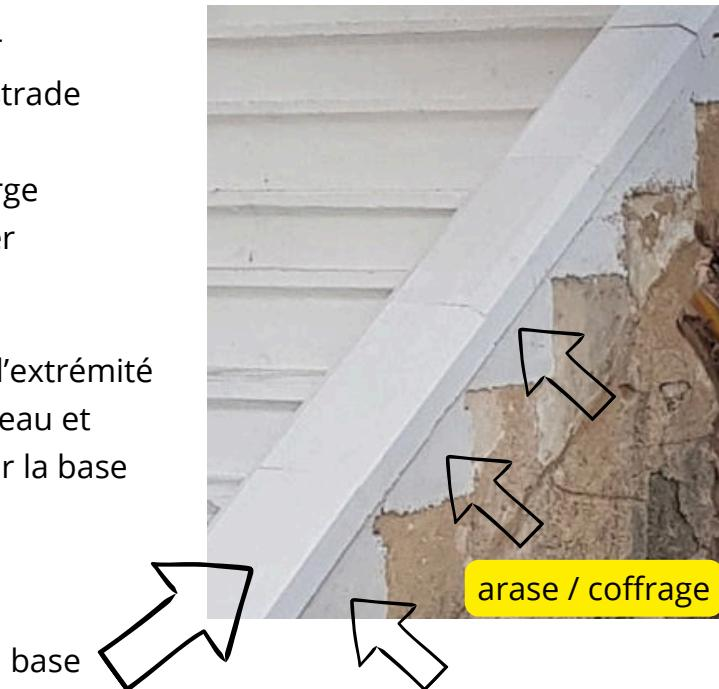
exemple d'arase (partie en béton pour compenser la hauteur des marches)
