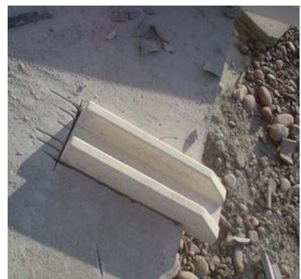
5. Coller la gargouille à l'aide d'un mortier colle à carrelage.
