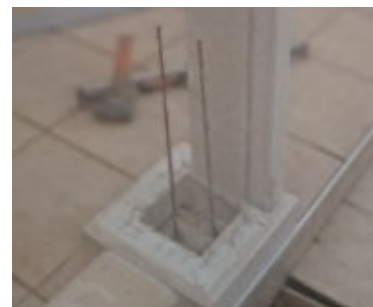
photo exemple ferrailage
