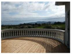
Vendue au mètre linéaire, celui ci comprend : Pour la série 820 : 2 Lisses basses, 4 balustres et 2 mains courantes Pour la série 860 : 1.33 lisses basses, 4 balustres et 2 mains courantes Pour la série 950 : 1.33 lisses basses, 4 balustres, 1.33 mains courantes et 1.33 tablettes Pilier complet vendu séparément.
