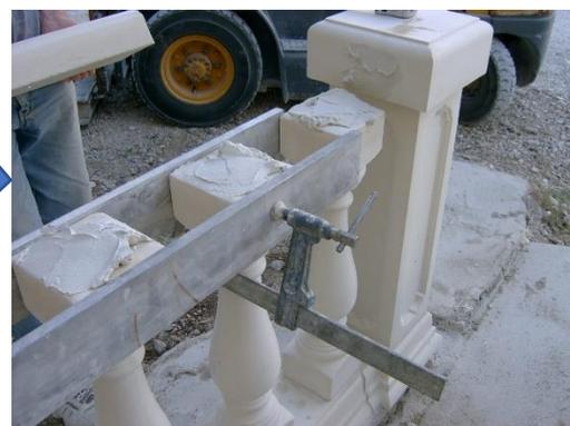
16. Sceller la main courante sur chaque balustre. A l'intérieur placer 2 fers tors de 6 à 8mm entre chaque pilier
