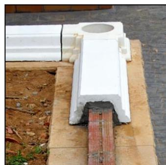
3. Dès les bases posées, les aligner à l'aide d'une règle ou d'un cordeau et bien vérifier le niveau de celle-ci.
