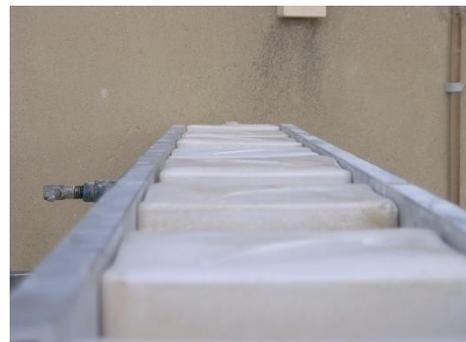
12. Ne pas oublier de vérifier les écartements des têtes de balustres, qui doivent être identiques au pied de la balustre.
