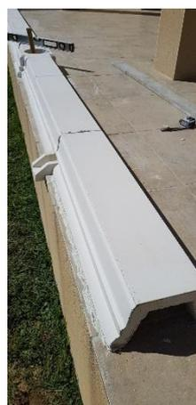
2. Une fois les bases positionnées, les retirer et mettre soit des plots de mortier épais ou poser une file de briques sur une épaisseur de mortier
