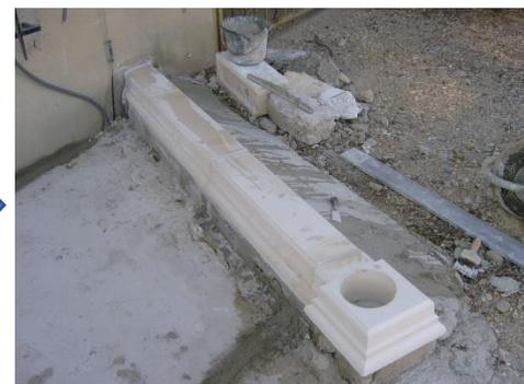
5. Coller le corps du pilier et remplir à moitié de mélange béton maigre (1 volume de ciment, 5 volumes de sable)
