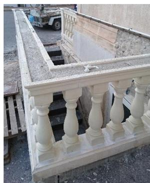
18. Coller le couvercle sur la main courante avec un cordon de mortier colle à carrelage après avoir balayé la partie inférieure de celui-ci.
