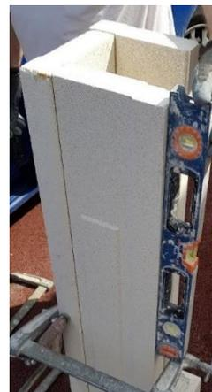
5. Posez les serre-joints au fur et à mesure de la pose du pilier pour bloquer.
