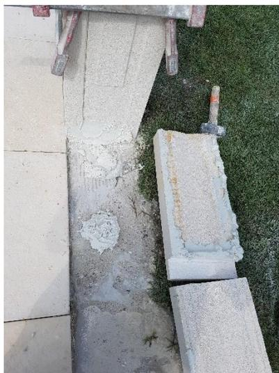
3. Dès les bases posées, les aligner à l'aide d'une règle ou d'un cordeau et bien vérifier le niveau de celle-ci.
