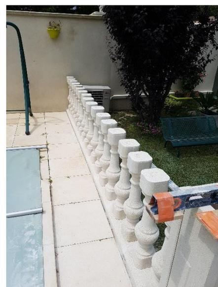
8. Une fois les écartements OK incliner la balustre au maximum pour glisser la colle sous le pied de la balustre.
